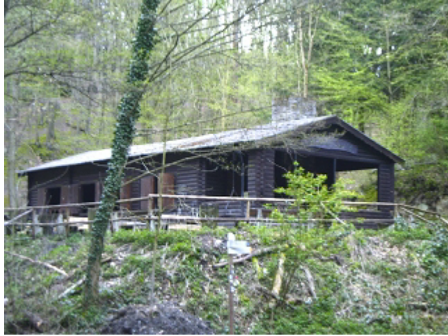
Schutz- und Grillhütte oberhalb der Klamm
