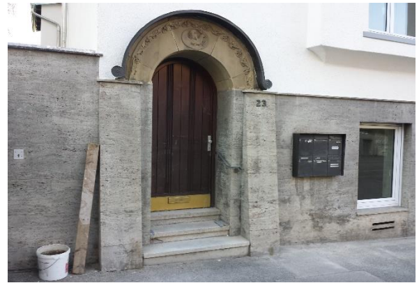
Libanonstr.23, erhaltener Haustürbogen
