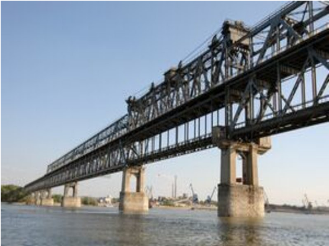
Die Donaubrücke in Russe
